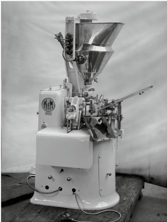
**Mit der Tubenfüll- und Schließmaschine TF 2 gelang der IWK 1955 der Durchbruch |**
